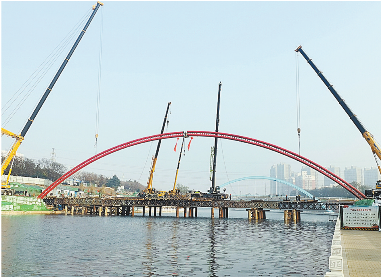
12月8日,平顶山集中供热蒸汽管网扩建项目跨湛河桥梁工程钢拱吊架顺利合龙,该项目由平煤神马建工集团承建、平煤杭萧建设工程有限公司负责制作和安装。 “热流”过湛河 该项目位于凌云路湛河桥以东众福桥以西,是河南省热力系统首座具有景观性质的热力桥。施工方采用装配式钢架桥取代土袋围堰筑岛施工的方式,最大限度保护湛河水质、缩短施工周期,打造美好景观。 本报记者 高轶鹏 摄
