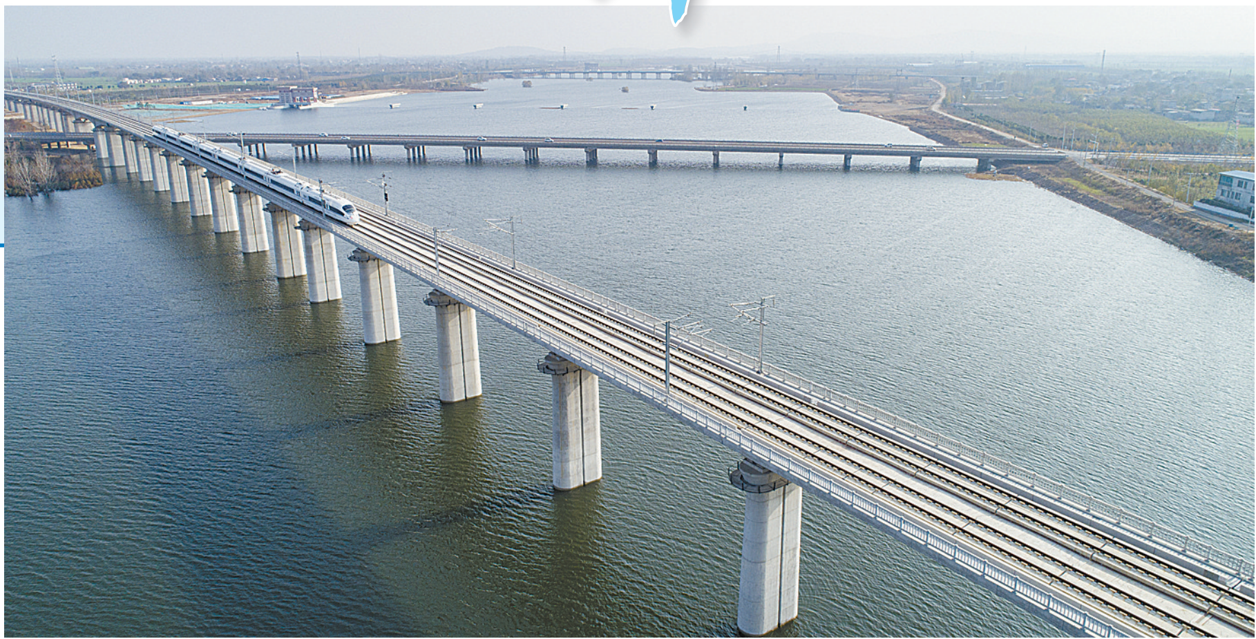
12月1日上午11:25左右,G7978次南阳东至郑州东列车经过北汝河大桥驶向郑县站。李利国 摄
