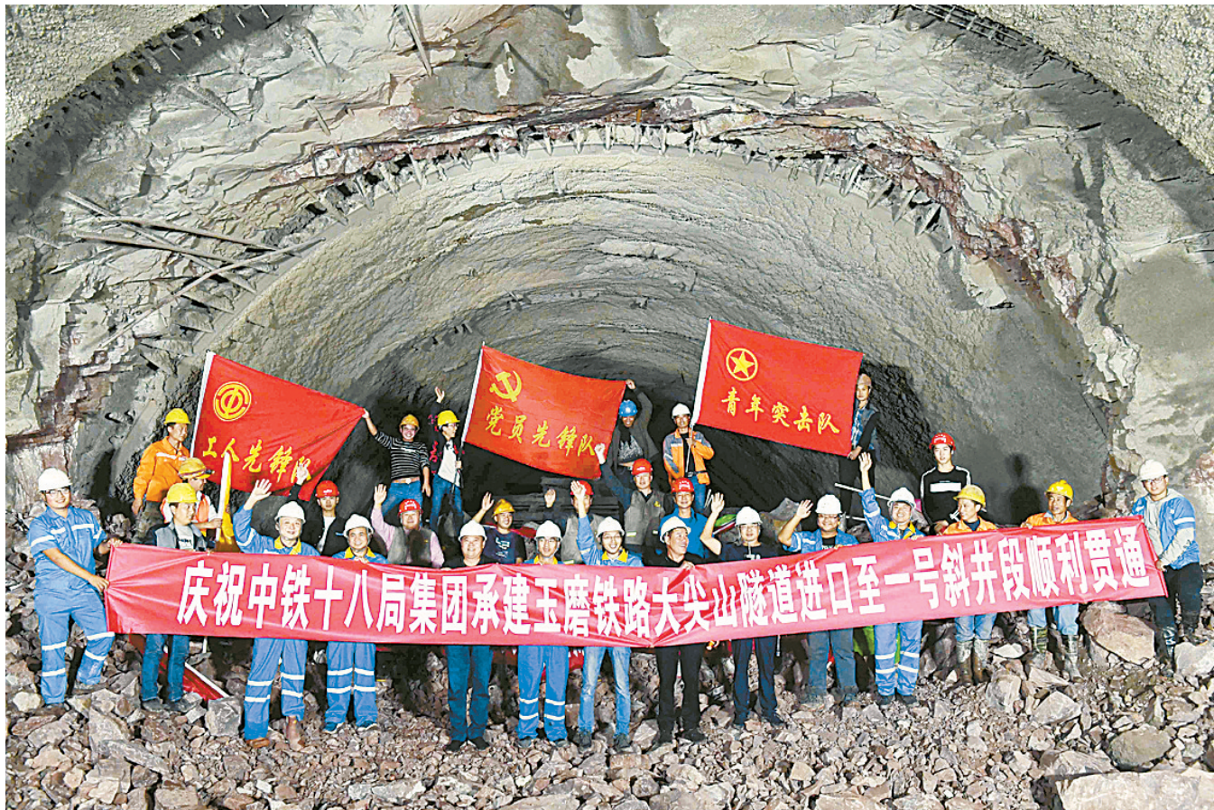
玉磨铁路大尖山隧道进口至一号斜井段顺利贯通
