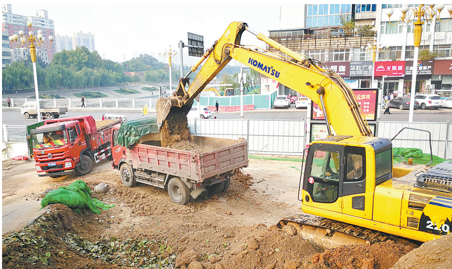
供暖管网紧张建设中
