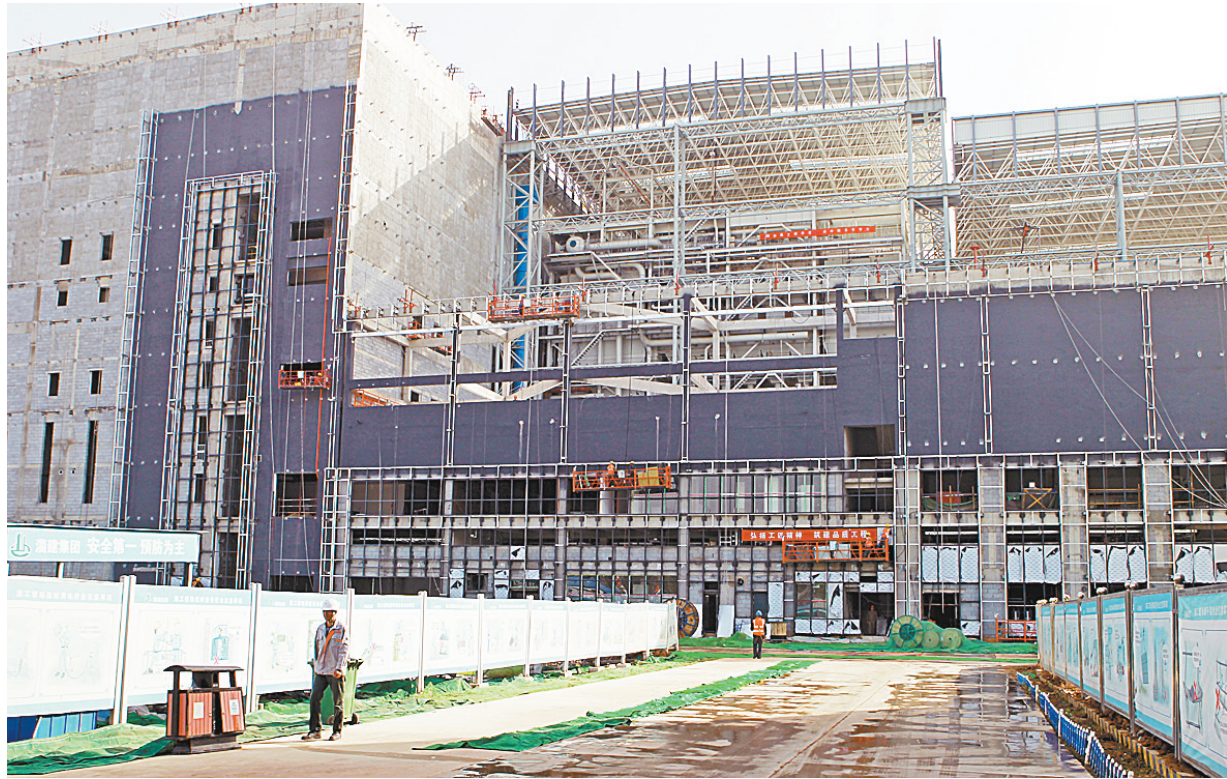
加快建设生活垃圾焚烧发电项目
