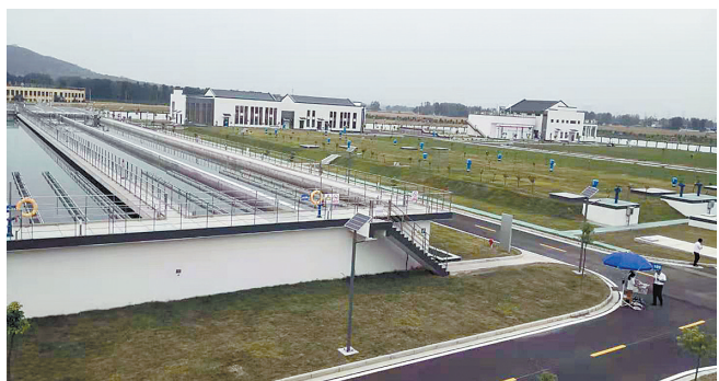
该集团承建的南水北调平顶山焦庄水厂供水工程
