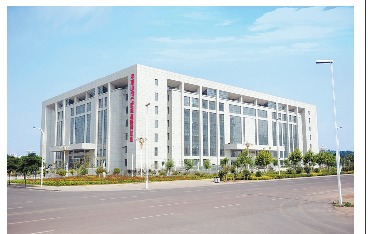
该集团凭借承建的平顶山市行政服务综合楼,首次荣膺鲁班奖,这是平顶山市第一个鲁班奖
