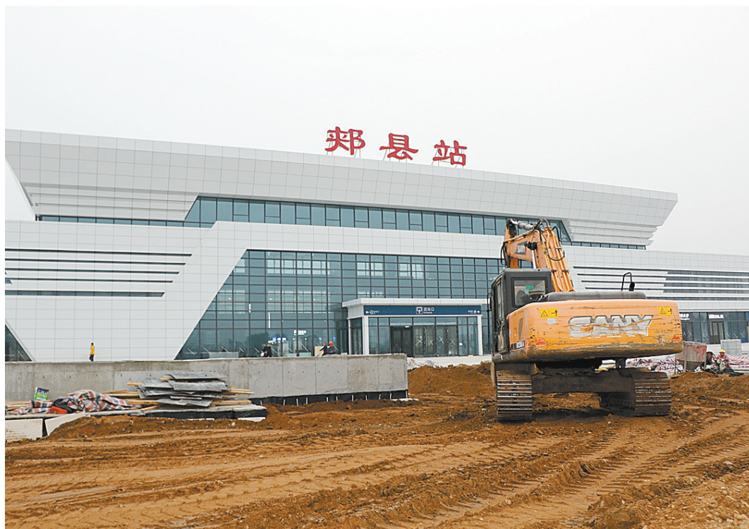
高铁站施工忙
