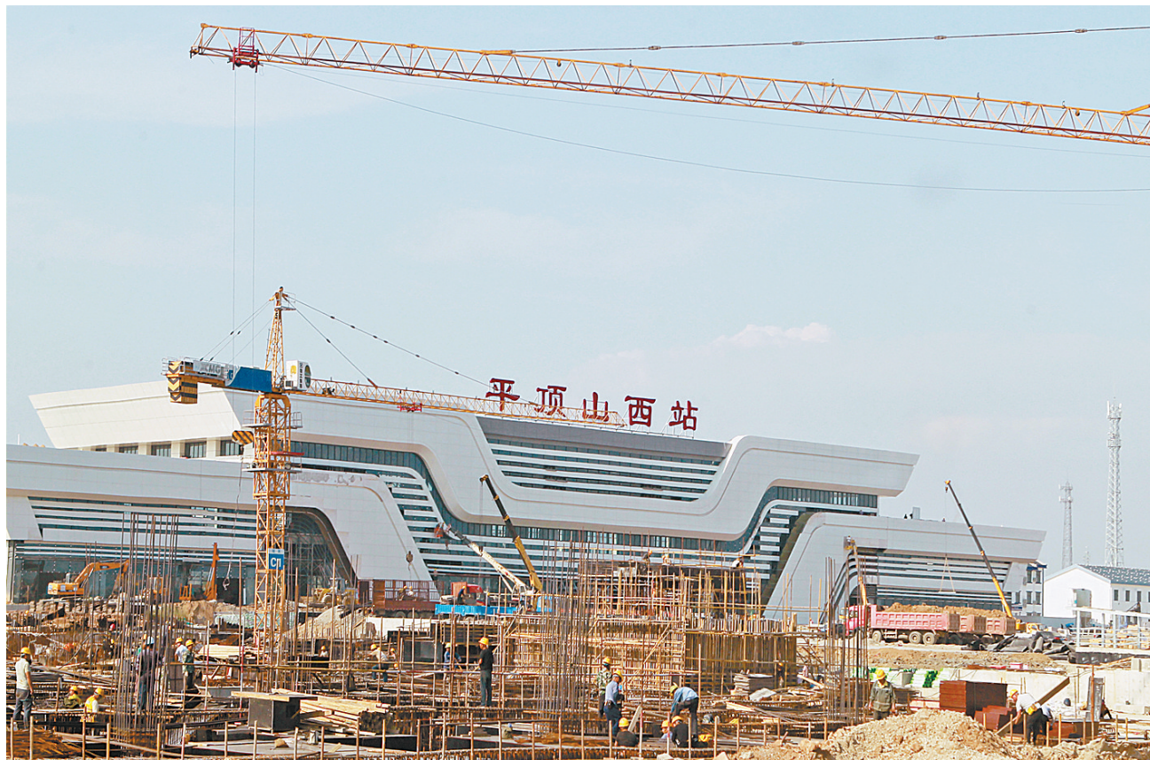
加紧建设郑万铁路平顶山西站 23.125万平方米,总建筑面积15998.1平方米,远期高峰小时发送量为3034人,站场规模3台7线,设计日均发送旅客能力0.8万人次。连日来,施工单位增派人员及施工机械,加紧建设,力争早日建成投入使用。 本报记者 牛智广 摄
