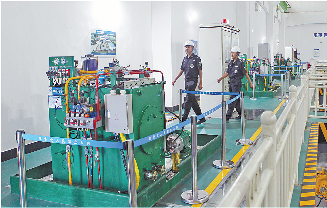
水北调工程是综合规模世界第一、全世界受益人数最多的水利工程,该工程在鲁山境内河段全长42.913公里,其中沙河渡槽工程是南水北调中线规模最大、技术难度最复杂的控制性工程之一,工程总长11.938公里。2014年12月12日正式通水后,鲁山管理处强化细节,认真做好沿线水质监测、沿线污染源防控工作,确保水质安全、运行安全。 本报记者 牛智广 摄
