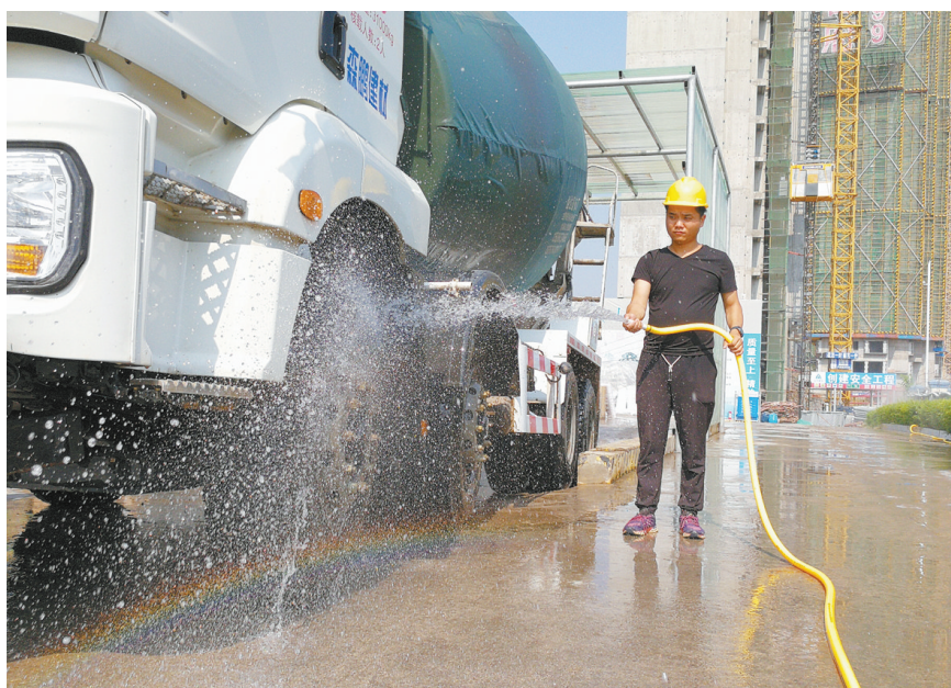
8月23日，稻香路南段某在建工地的施工人员对驶出车辆进行二次冲洗。为抓好环境污染防治工作，该工地在出口处设置了清洗池和智能冲洗系统，对所有驶出工地车辆进行清洗，避免车辆带泥上路。 本报记者 姜涛 摄
