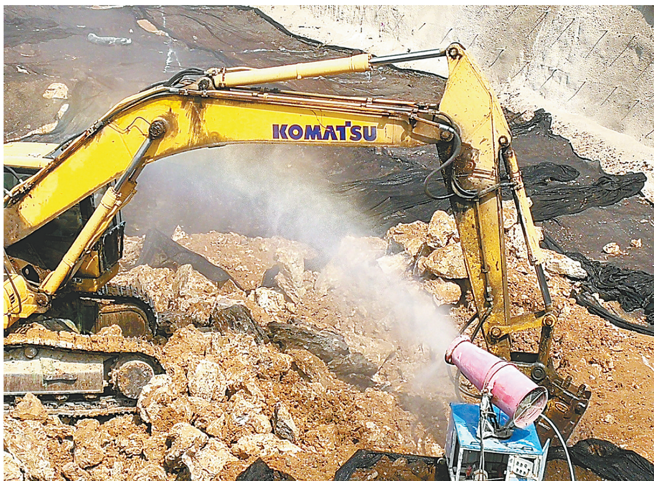
施工喷淋 避免扬尘
