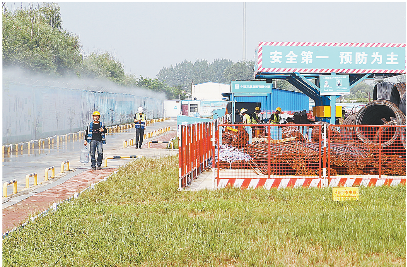
施工抑尘同步推进
