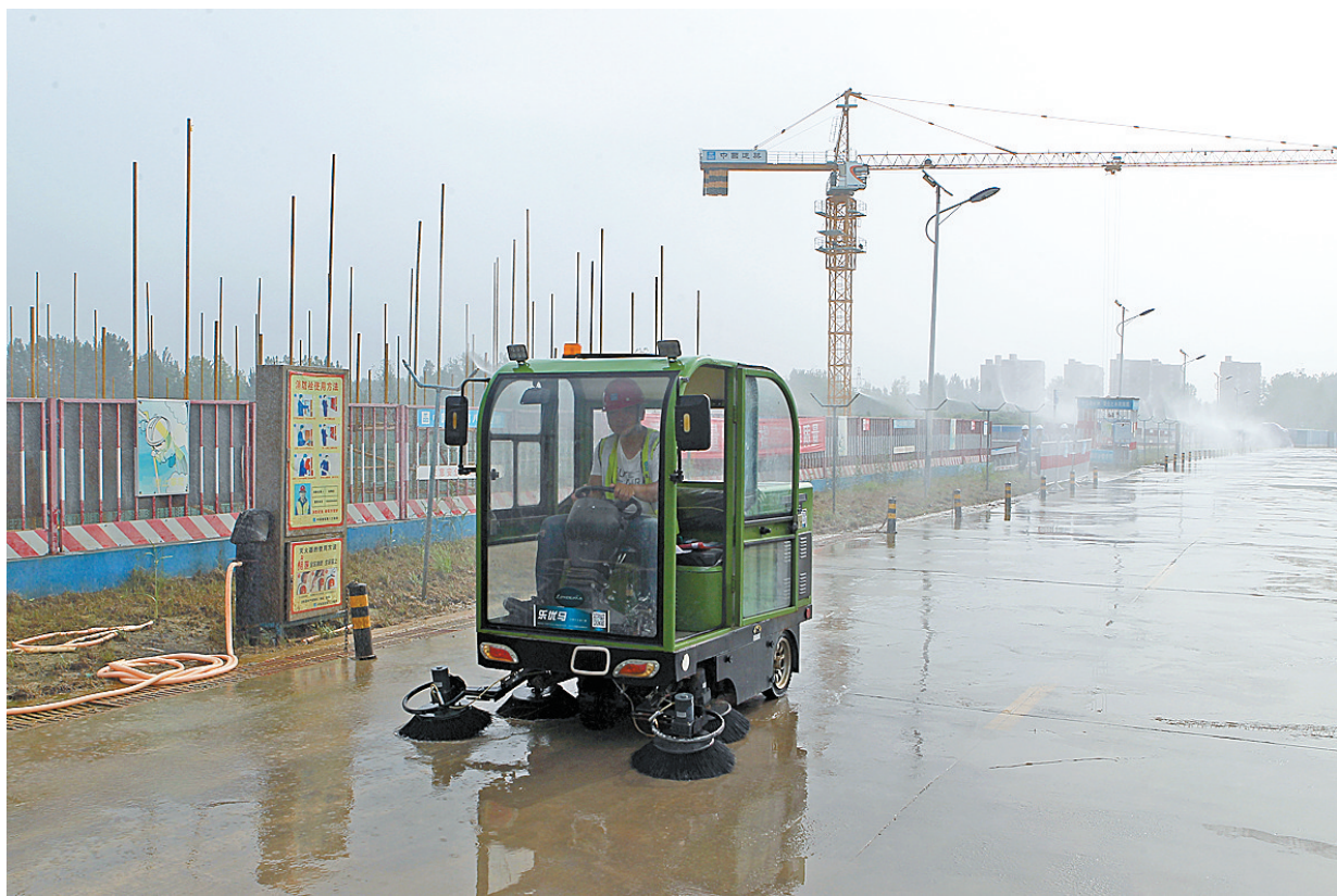
施工不忘抑尘
