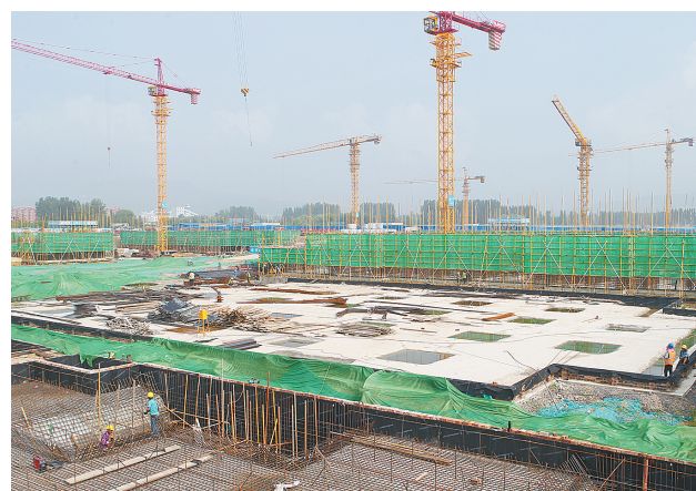
加紧建设棚户区改造项目
