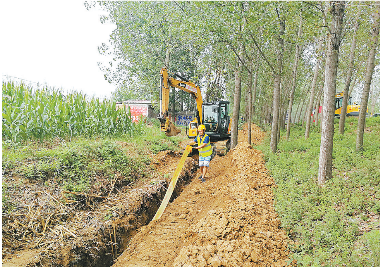
铺设天然气管道
