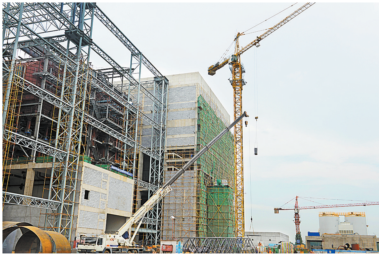
加紧建设城市生活垃圾发电项目
