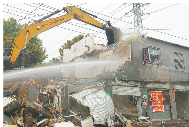
6月25日,在卫东区北环路街道下牛村岳庄组,一辆挖掘机在洒水车的配合下拆除占压西杨村河道的违章建筑。违章建筑拆除后,培英街将进行拓宽改造,平安大道与虞城大道之间将再添一条南北连接的通道,方便附近居民出行。本报记者 田秀忠 摄
