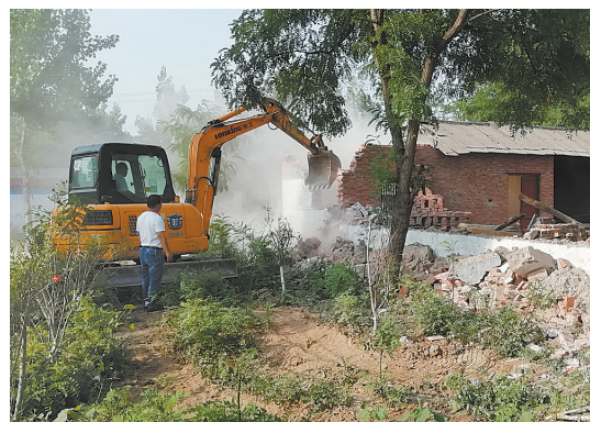
肖旗乡岭湾村违建拆除中。
