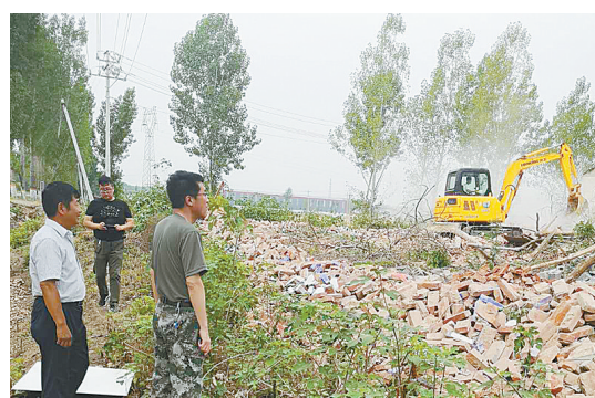
石桥镇邢庄酒厂违建拆除中。
