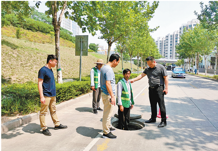
日前,在新城区福佑路中段,工作人员在对原有的窨井防坠网进行检查。 目前,示范区2800个窨井、
