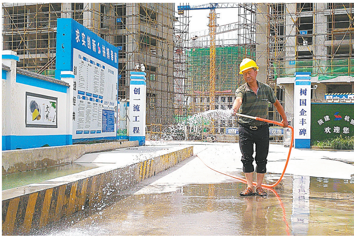
冲洗施工道路抑制扬尘
