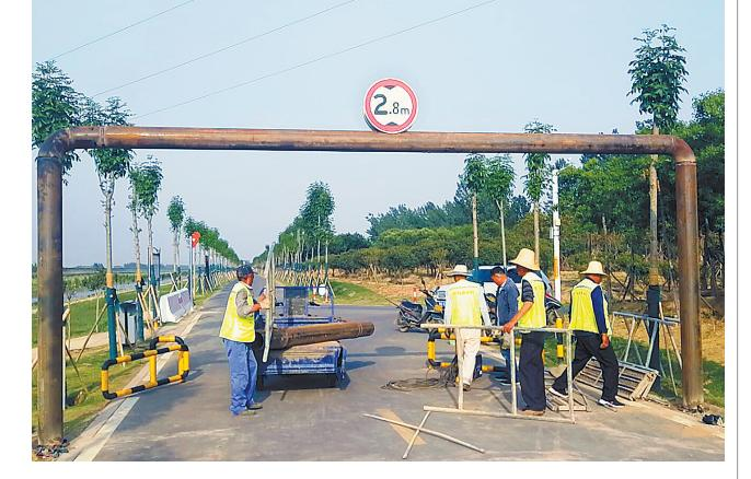
5月20日,工作人员在湛河高新区 段为堤顶路加装限高门架。
