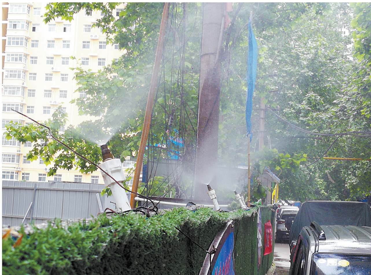
5月13日,和顺路西段一个在建项目工地外墙上的喷淋系统向工地内外喷洒水雾抑制扬尘。为做好污染防治工作,该项目建设方在工地围墙上设置了喷淋系统,防止施工扬尘造成环境污染。 本报记者 姜涛 摄
