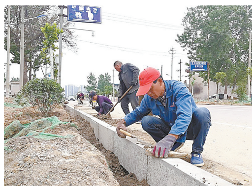
平桐路一侧,工作人员在铺设绿石。
