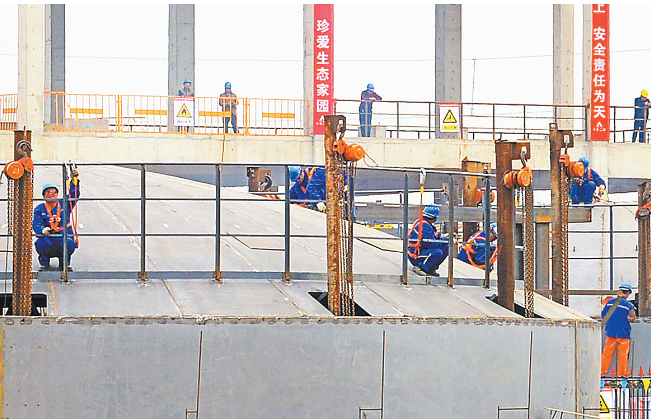
加紧建设 4月22日,工人们在平煤神马集团尼龙科技有限公司年产15万吨环己酮项目
