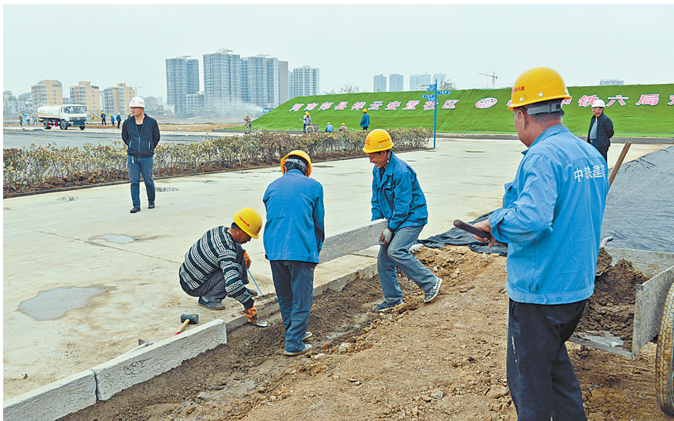
加紧建设棚户区改造项目
