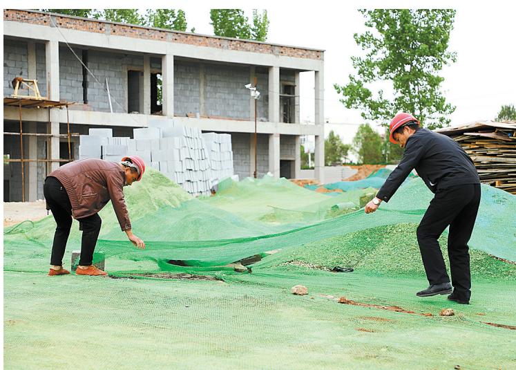
4月18日,施工人员在加紧建设河南神马锦纶科技有限公司民用丝工程项目,施工楼体和周边未施工土地全盖了防尘网。该项目是我市长尼龙产业链的战略规划,是河南省产业集聚区重点项目之一。该项目从开工伊始就做好防尘抑尘工作,除对裸露土地加盖防尘网、设立车辆冲洗设施外,还进行喷雾、洒水抑尘。 本报记者 牛智广 摄
