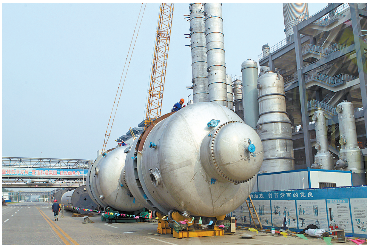
20万吨己内酰胺项目二期工程进入设备安装阶段
