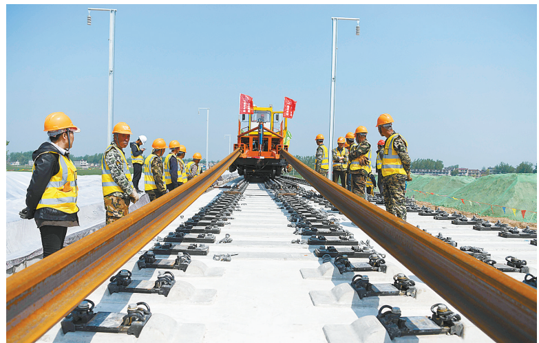
郑阜铁路安徽段全线进入铺轨阶段
