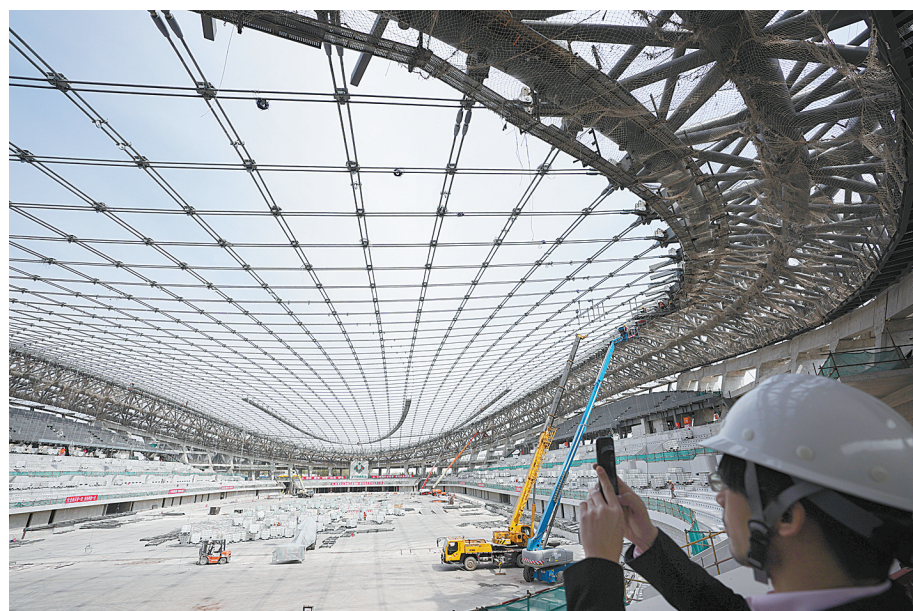
近日,国家速滑馆屋面膜网结构张拉工程全部完成,标志着国家速滑馆结构体系基本形成...
