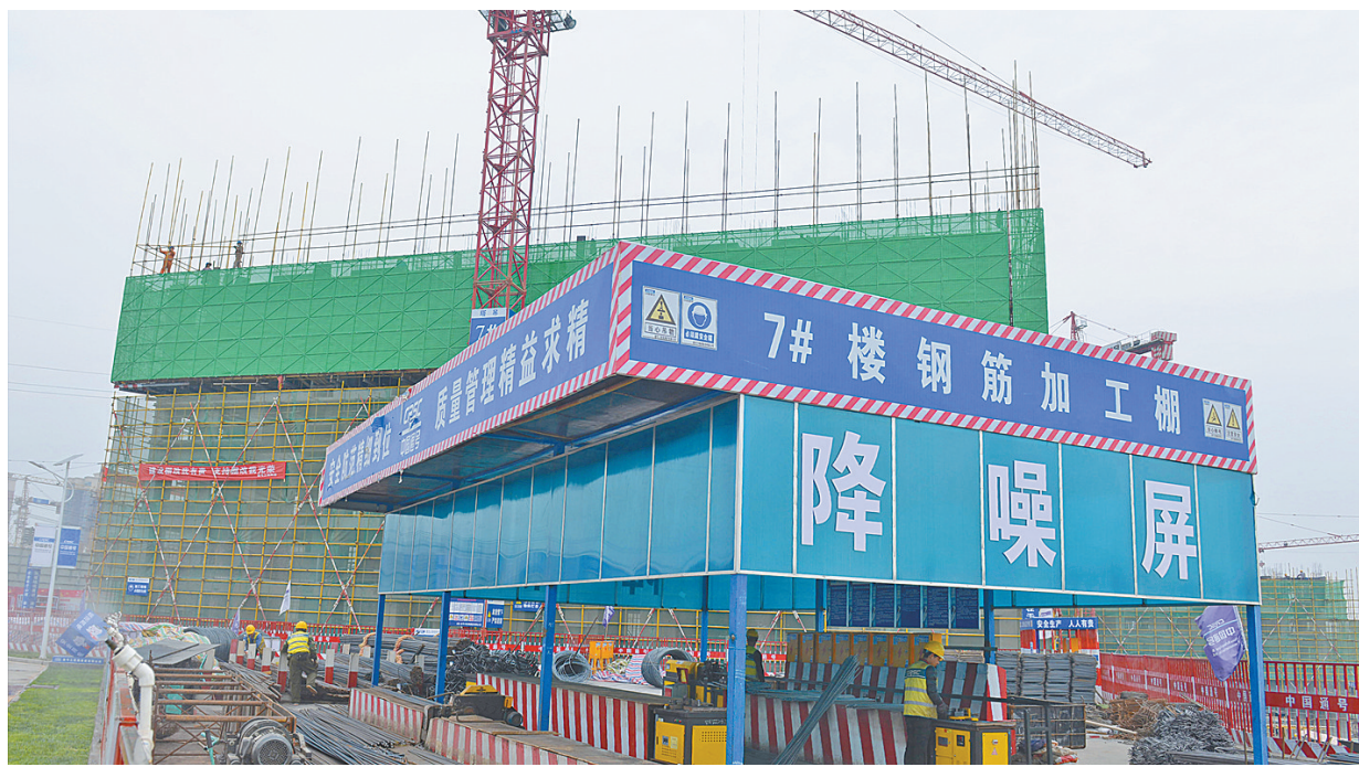
同岭棚户区改造项目加紧施工
