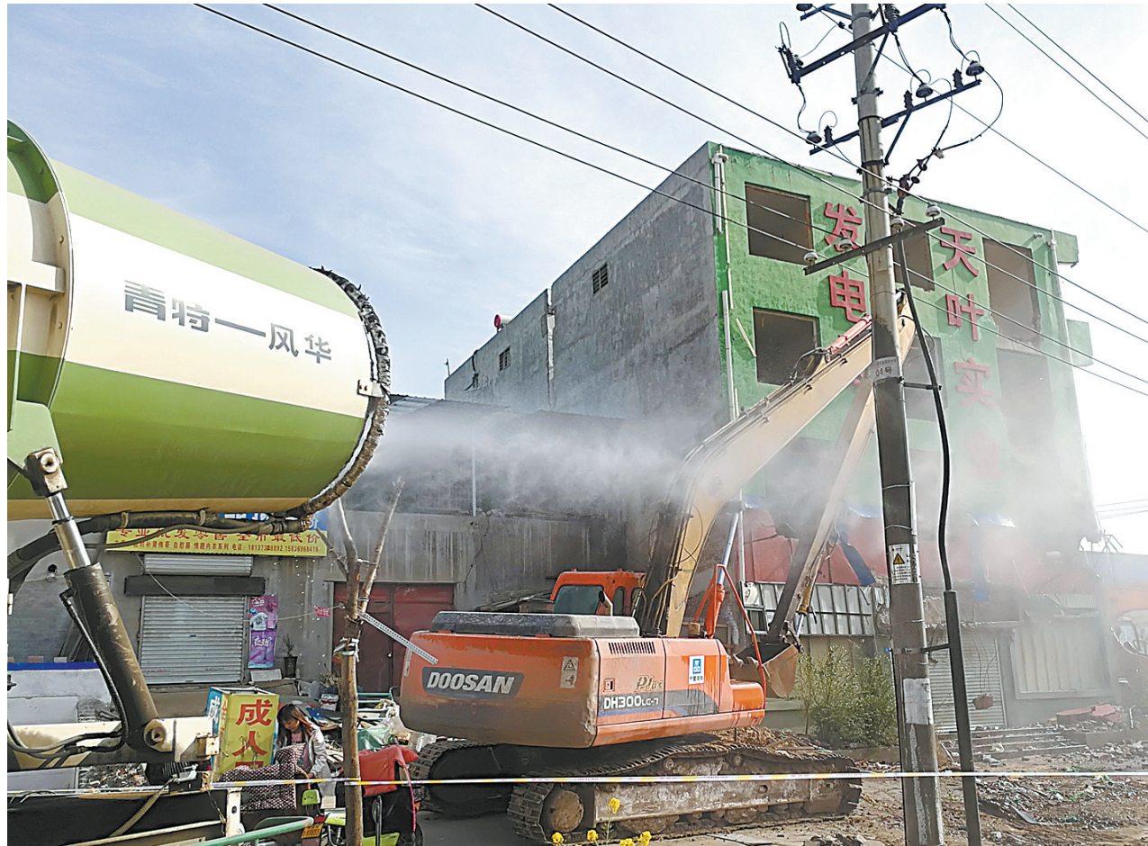
施工喷淋 抑制扬尘
