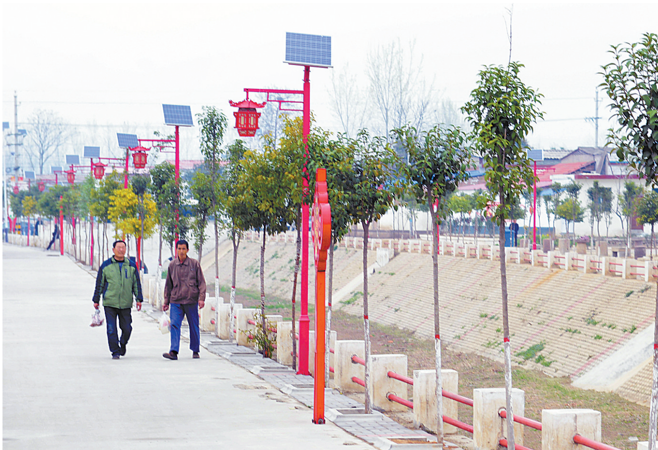
为扎实推进农村人居环境整治工作，该村筹措资金，发动群众硬化村内道路，增加绿化面积、安装光伏路灯、修建休闲游园，并对民居外墙进行了
