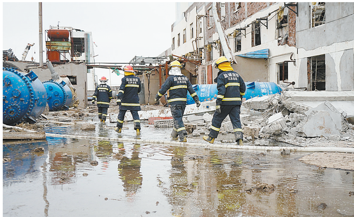
在“3·21”响水天嘉宜公司爆炸事故现场，江苏消防救援总队盐城支队的队员展开搜救（3月22日摄）。新华社发
