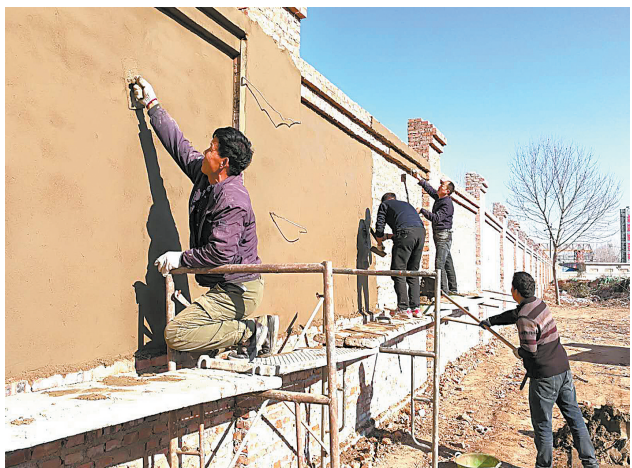
1月22日上午,施工人员在湛河区平桐路景观大道谢庄村段西侧修建景观墙。 本报记者 姜涛 摄
