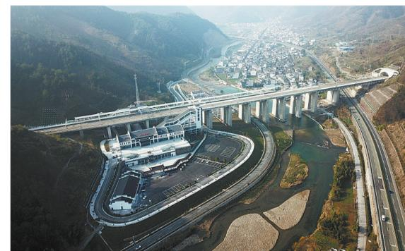
杭黄高铁即将开通。图为12月24日在安徽省黄山市歙县三阳镇拍摄的杭黄高铁线的高速铁路，设计时速250公里，由中国铁建铁四院总体设计。即将开通的杭黄高铁是连接浙江省杭州市与安徽省黄山市的高速铁路。新华社记者 邢广利 摄
