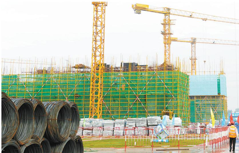
12月11日，施工人员从工地内部硬化的道路上通过。宝丰县周庄镇皮庄棚户区改造项目建设单位使用防尘网对建筑施工区域进行立体封闭，并硬化道路，栽种草坪，努力减少扬尘污染。
