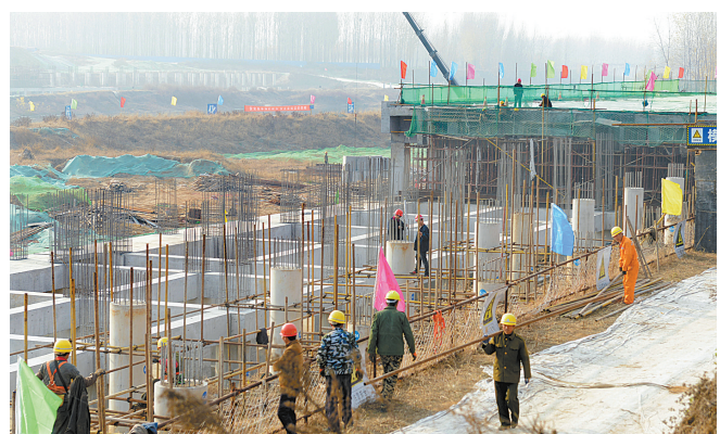
加快推进沙河复航平顶山段建设
