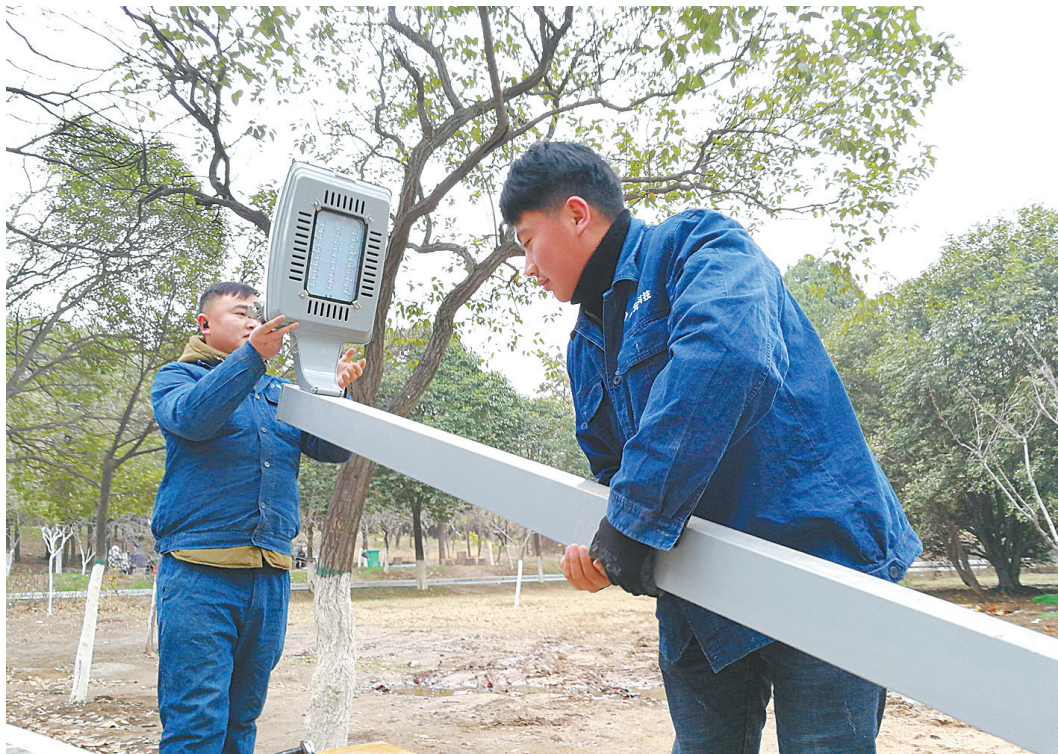
12月6日,施工人员在河滨公园内安装LED路灯。
