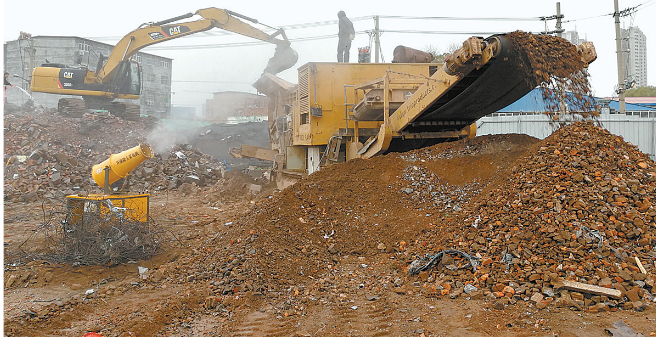
粉碎建筑垃圾
