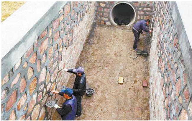
12月3日,工作人员在湛河下游高新区段用水泥为一处新建的雨水涵入河口挡墙勾缝。为做好环境污染防治工作,市湛河治理工作指挥部对河道沿线的雨水管涵及其入河口进行了改造,消除污染隐患。本报记者 王尧 摄
