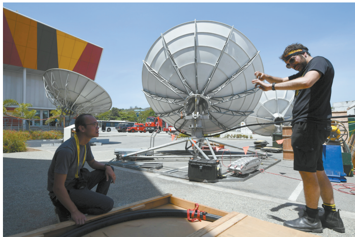
11月13日,工作人员在巴布亚新几内亚首都莫尔兹比港的APEC国际媒体中心安装卫星设备。
