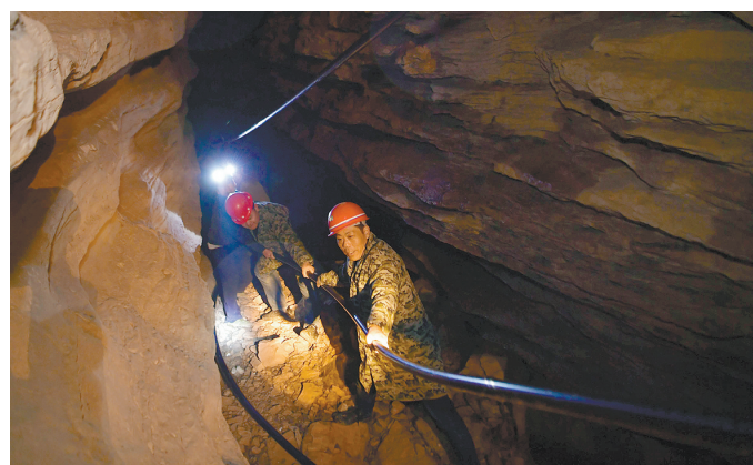
11月13日,探水队队员在天窗洞内铺设水管。
