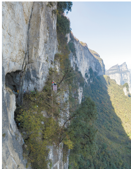
朝东岩绝壁中间的天窗洞(10月31日无人机拍摄)。
