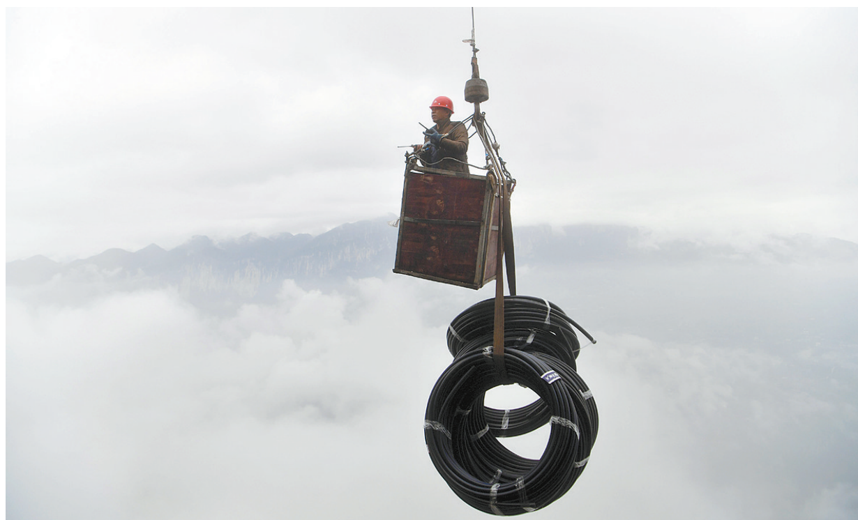
11月13日,探水队队员通过铁吊篮运送水管到天窗洞内。
