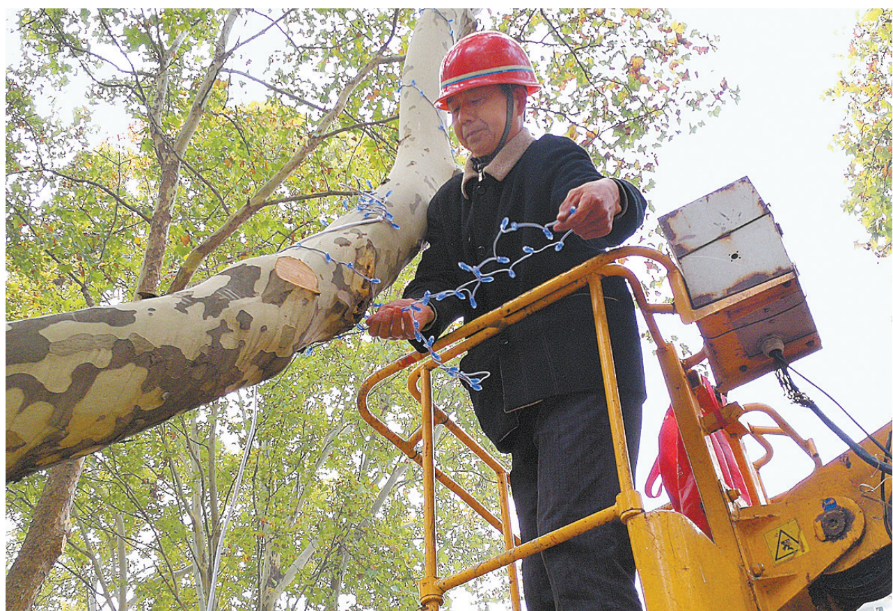
安装行道树景观灯
