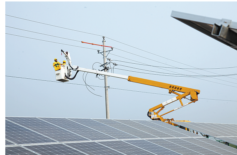
村级集体光伏发电项目施工现场
