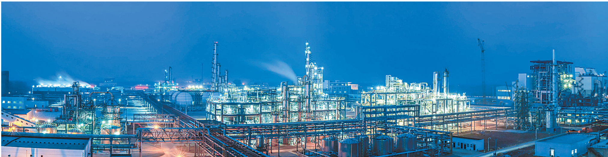
尼龙科技公司厂区
