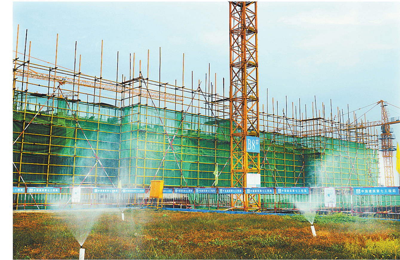
10月30日,宝丰县皮庄棚户区改造项目工地正在喷雾抑尘。为做好环境污染防治工作,该项目建设单位围绕施工区域安装了防尘网和喷雾抑尘装置,并在工地内部空地上种植了草坪,努力消除建筑垃圾扬尘隐患。
