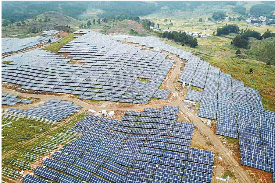
土建处第三安装工程部承建的河北沧州南皮县50兆瓦光伏并网发电项目,项目总投资4.15亿元,其中土建处承揽1.73亿元。杨禹杰 摄
