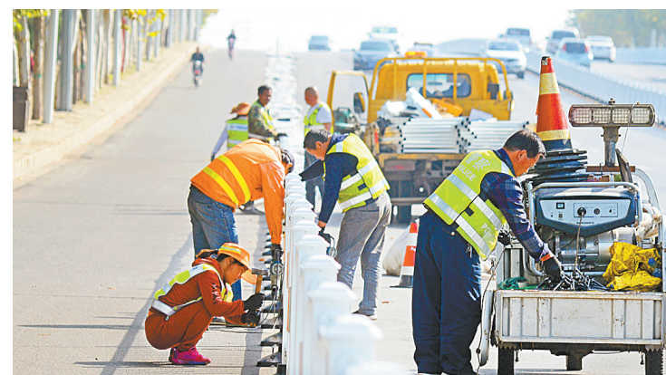
10月23日,工作人员在新城区长安大道东段更换非机动车道隔离护栏。为提升城市形象、完善交通
