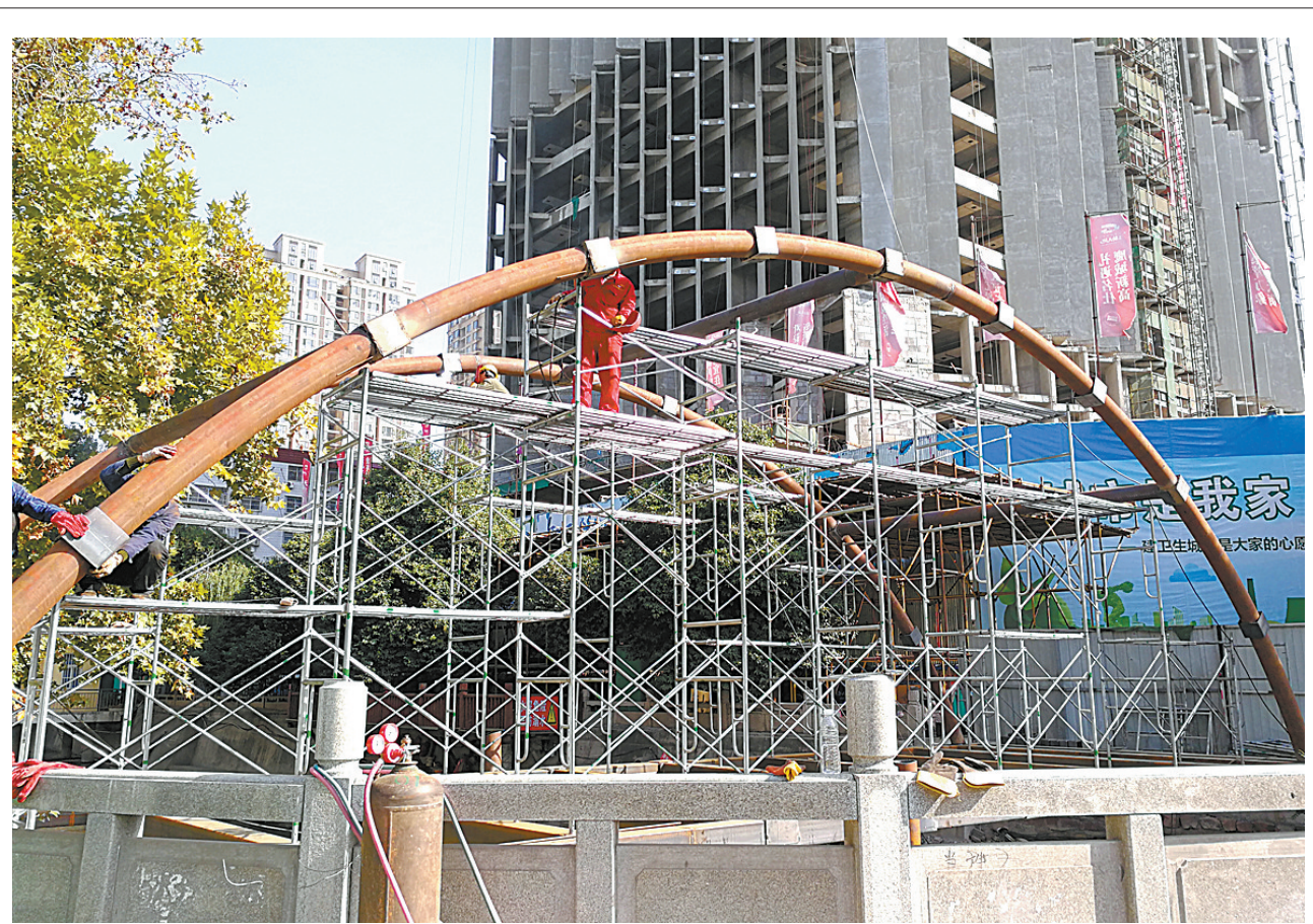
推进市政设施建设
