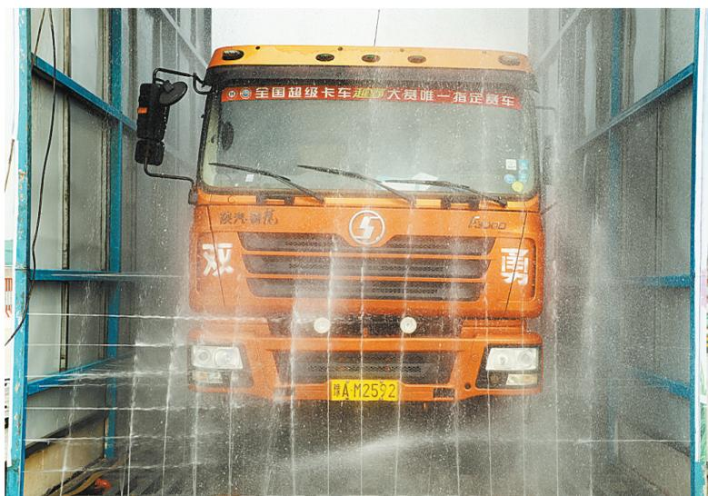
10月18日上午,一辆待外运渣土车在进行冲洗。为减少道路扬尘污染,杜绝渣土运输对环境造成二次污染,石龙区棚改区项目之一永康苑工地严格“五化标准”等相关要求,对工地主干道全部进行硬化,明确环保监督员、网格员、管理员工作制度,坚持24小时湿法作业。本报记者 张鸿雨 摄
