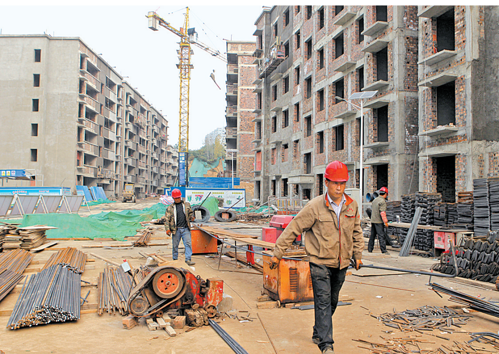
加紧建设 易地搬迁项目
